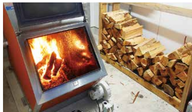
三瀬コミュニティセンターでのエネルギー勉強会の様子と導入された薪ボイラ
